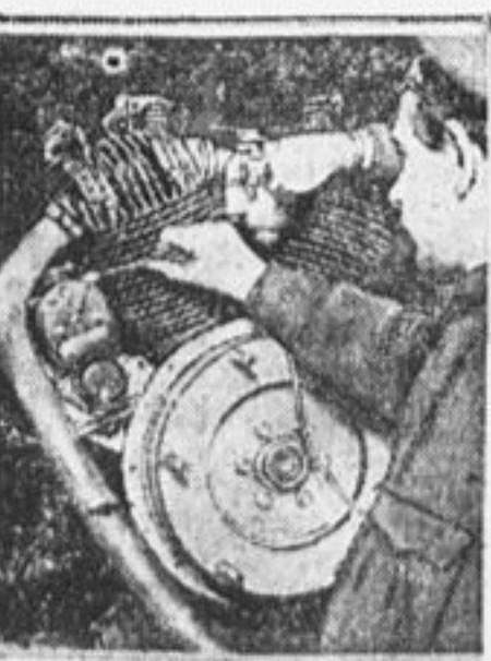
Заправка провода магнита на автомобильном заводе «Спартак», в Москве.
